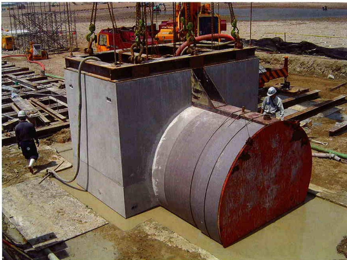
▲ Iホール潜函工法
