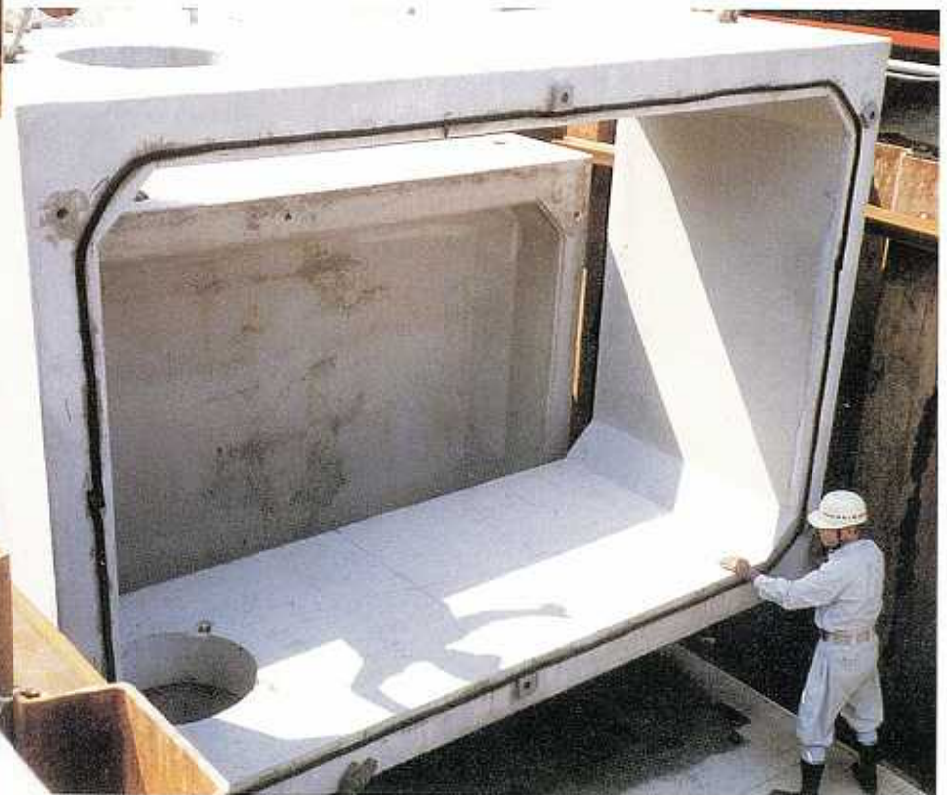
2 製品据付・組立
