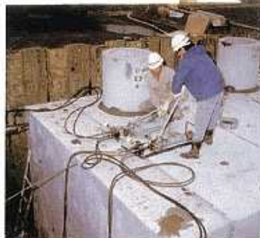
3 P C 鋼より線の緊張
