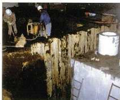
4 グラウト注入
