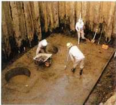
1 基礎ベースコンクリート状況
