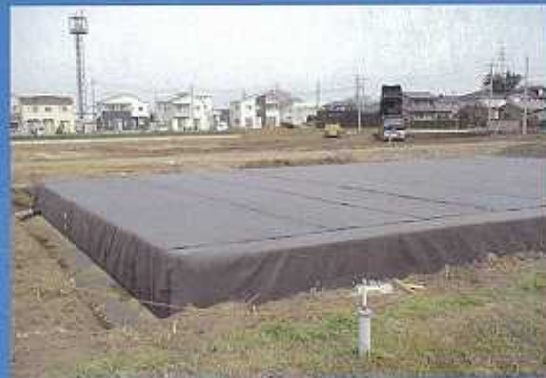
商業施設中規模貯留槽
