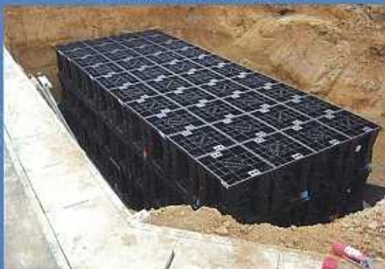
宅地造成小規模浸透槽
